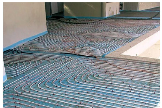
Abb. 28 | Fußbodenheizung
