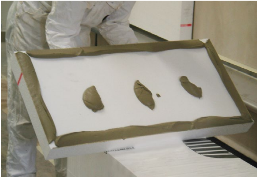
Abb. 10 | Kleberauftrag
