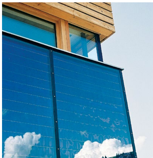
Abb. 41 | Fassadenintegrierte Solaranlage
