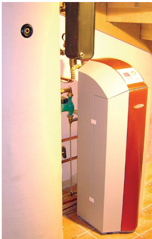
Abb. 31 | Wärmepumpe
